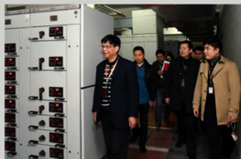
11月28日上午，院领导带领职能部门负责人及各党支部书记在配电房进行安全大巡查
